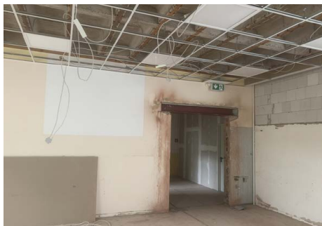
Sanierung GS An der Bastau
