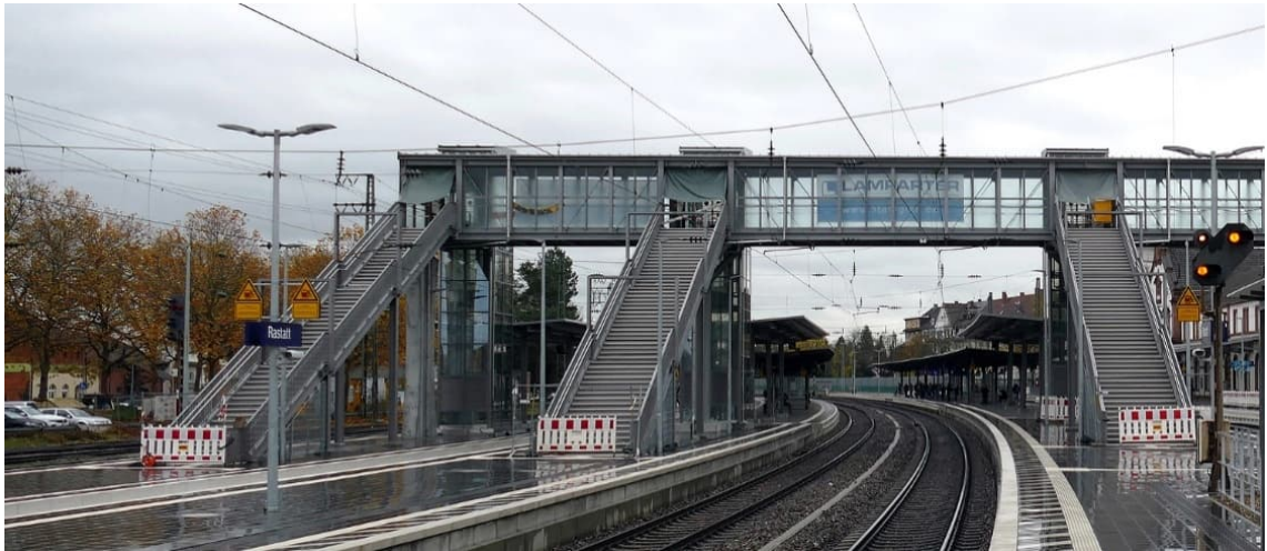
Abbildung 3: Beispiel Fußgängerbrücke über Eisenbahngleise (Quelle: BPR Dr. Schäpertöns Consult, München)
