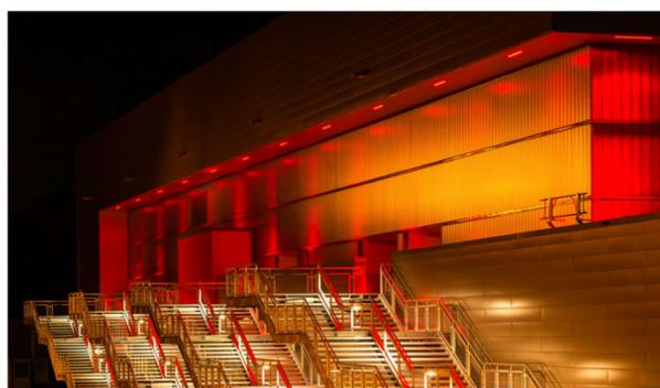
Einen Blickfang der Arena stellt vor allem die Außenhaut dar, die aus Metallplatten und Profilglaselementen besteht, die durch LEDs in unterschiedlichen Farben erstrahlen können.
