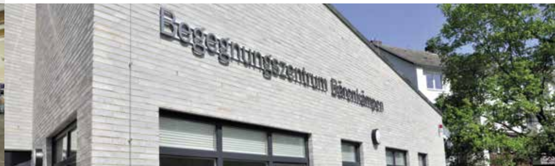
Neubau Stadtteilzentrum Bärenkämpen
