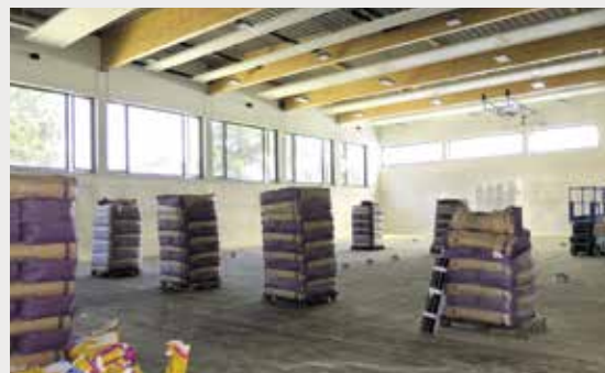
GS Hohenstaufenschule: Neubau Sporthalle
